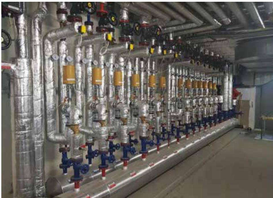
Verteiler Heizungsanlage mit Baelz-Strahlpumpen.
