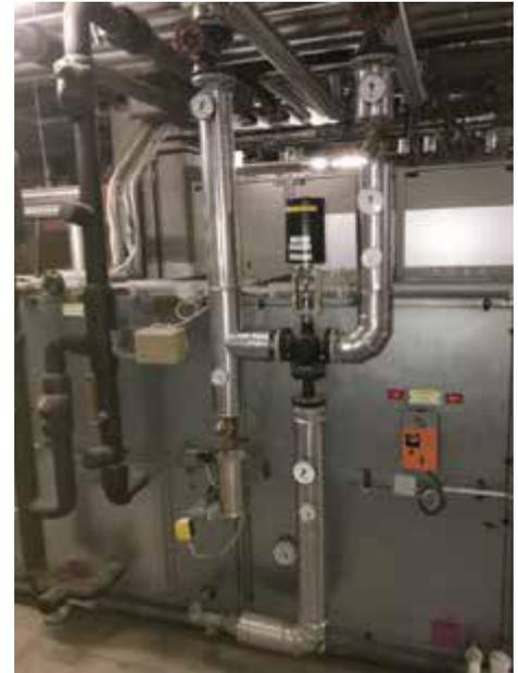
Strahlpumpe mit einer Lüftungsanlage.
