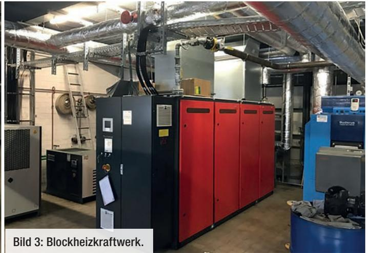
Bild 3: Blockheizkraftwerk.
