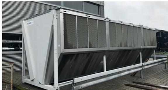
Bild 4: Trockenes Rückkühlwerk mit adiabater Vorkühlung.
