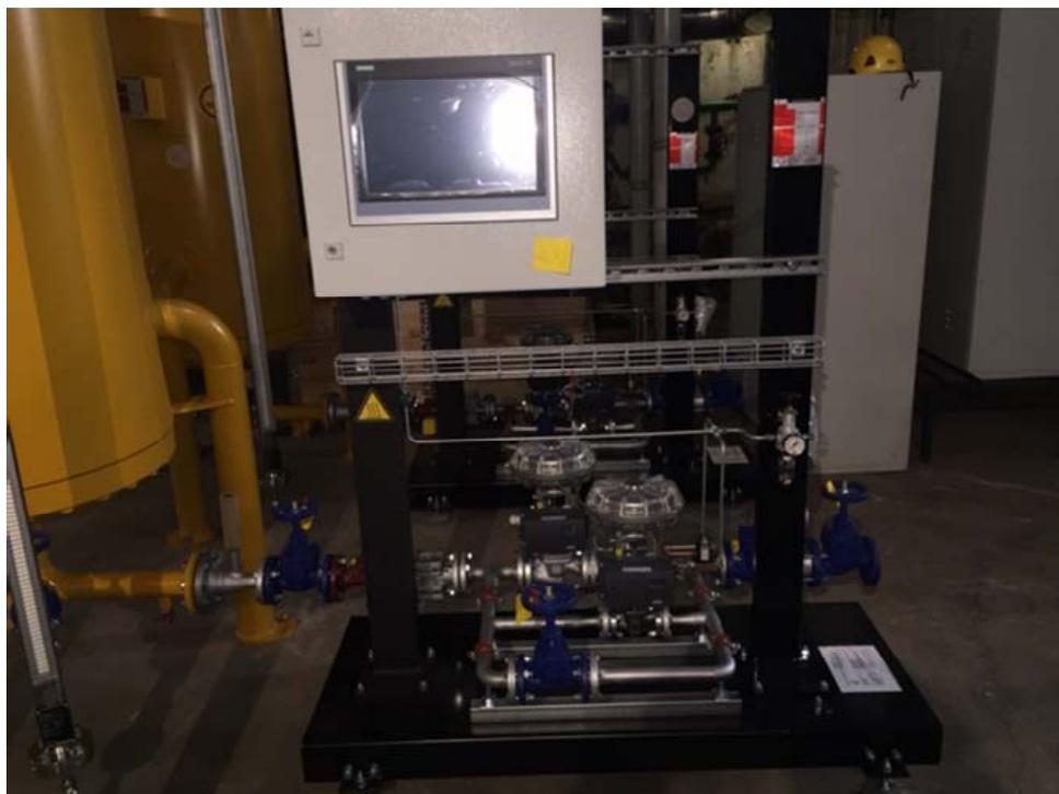
*Fig. 3 Régulation sur le côté condensat avec deux vannes de régulation en cascade piloté par un automate Baelz avec écran tactile*
