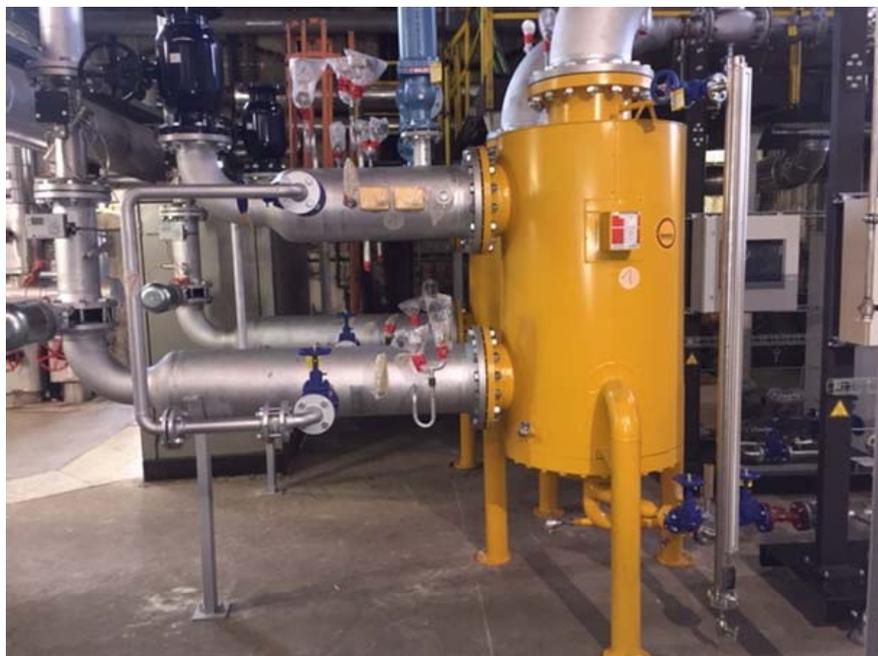
*Fig. 1 Station de transfert de chaleur fermée vapeur-eau*
