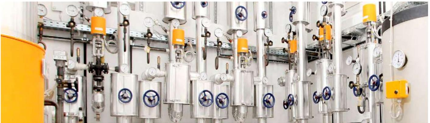
Wärmeübergabestation mit Strahlpumpen-Heizungsverteiler und Pufferspeicher; Baelz-Stammhaus, Heilbronn
