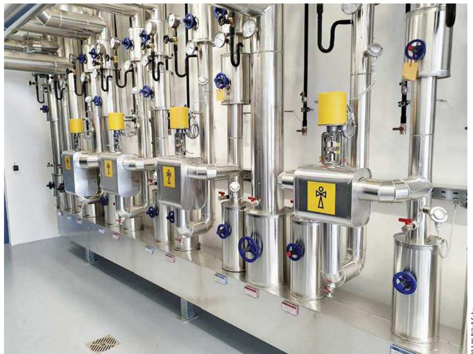
1 Heizungs- und Kälteverteiler Hydropilot mit Strahlpumpen-Aufbaugruppen.
