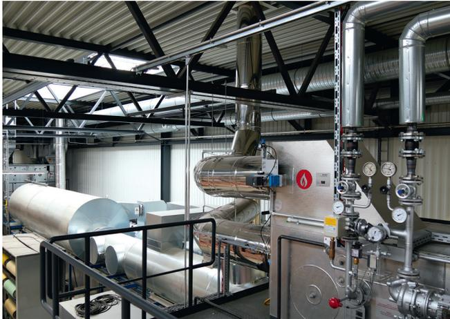
Sonderabgas-Wärmeübertragungssystem in Verbindung mit der Lackieranlage
