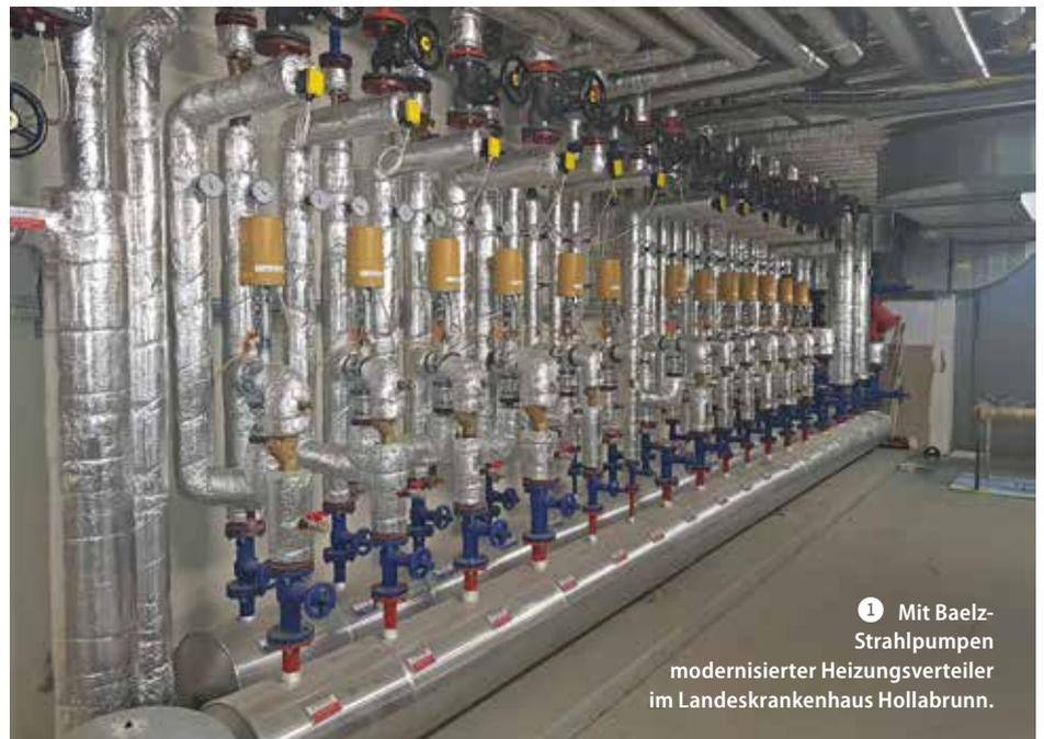
1 Mit Baelz-Strahlpumpen modernisierter Heizungsverteiler im Landeskrankenhaus Hollabrunn.
