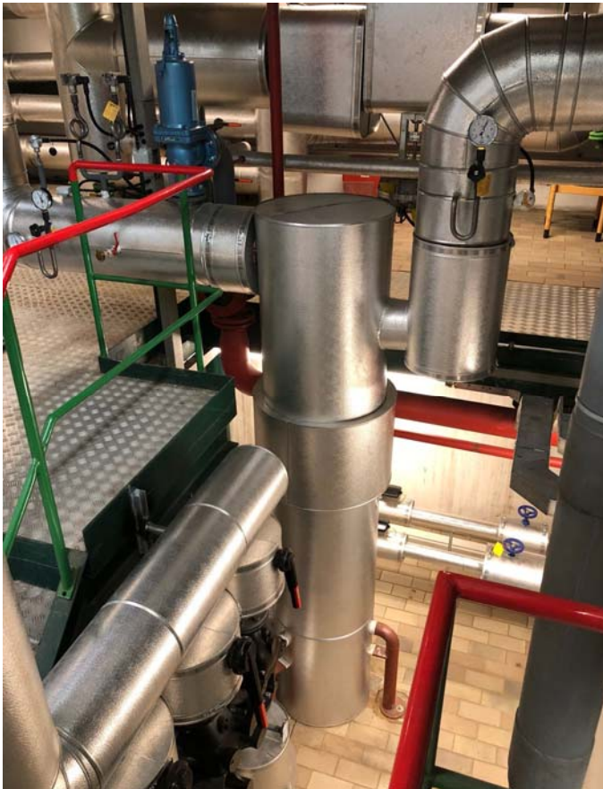
Figure 5 Échangeur de chaleur avec canal annulaire
