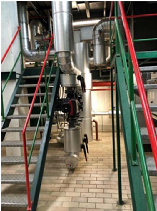
Figure 2 Échangeur de chaleur avec pompes de circulation secondaires
