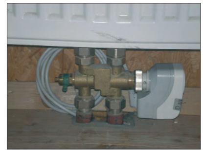
Bild 2. Vierweginjektionsventil am Energieabnehmer Quelle: Bälz
